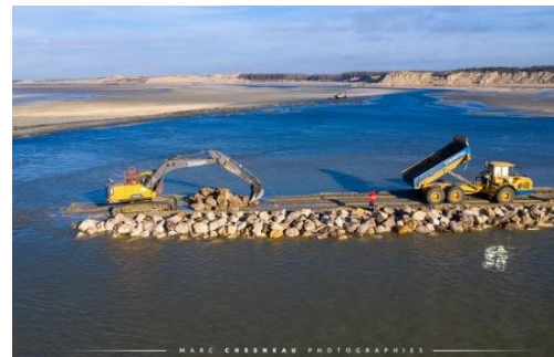
Construction d'un brise-lame
